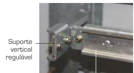
Suporte Horizontal com perfil DIN para fixar disjuntores bornes
